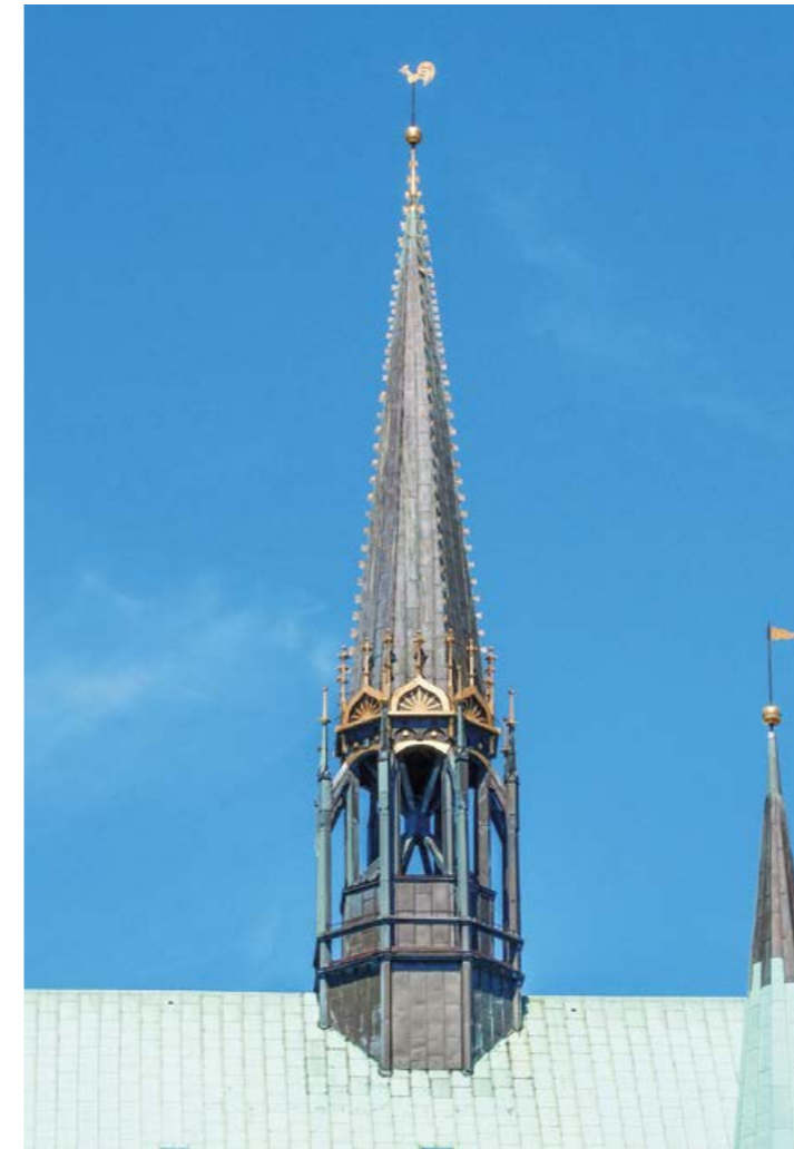
Der wiederhergestellte Dachreiter der Kirche St. Marien zu Lübeck.
